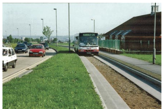
图6: Ipswich(英国)的公共汽车道使用植被和泥土,既能充分减少建设费用,又大大减少了噪声。 (Lloyd Wright, 2001)
