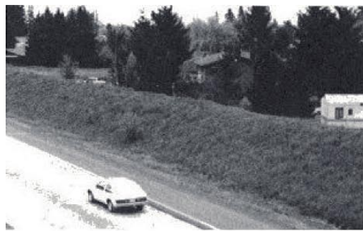
泥土道路隔离噪声设施
